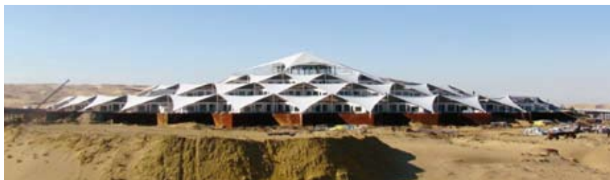
图8. 内蒙古鄂尔多斯库布齐沙漠上的薄壁轻钢建筑(四星酒店)
