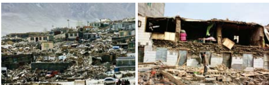
图2. 2010年青海玉树地震房屋破坏情况（此次地震7.1级，共造成3000多人遇难）
