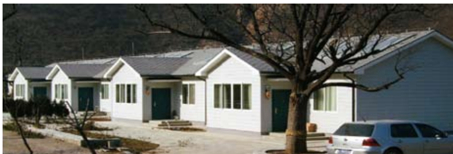
图9. 北京门头沟山区里的薄壁轻钢建筑(农村住宅)
